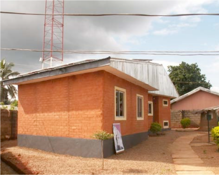
Figura 11.2: El NOC se construyó localmente con ladrillos de laterita producidos y colocados por jóvenes de Kafanchan.
