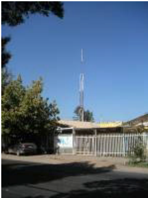
Figura 11.21: Nodo en el sur de Santiago. Consiste de una torre de 15 m, una antena Trevor Marshall 16 + 16 y 30 clientes. Está enlazado con un nodo en la zona centro a más de 12 km.
