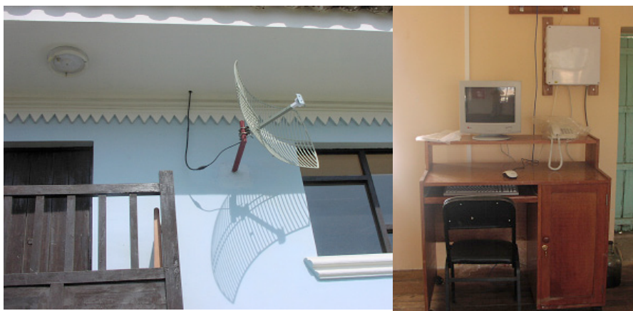
Figura 11.31: Kcaury . De izquierda a derecha: Antena direccional de 24dBi montada en brazo mecánico, estación de cómputo y caja de equipos de telecomunicaciones.
