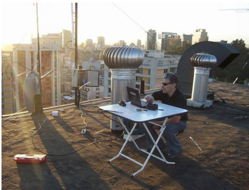
Figura 11.23: Nodo del centro conectado con el nodo del sur de Santiago. Se observa la antena parabólica que realiza el enlace y la antena ranurada para captar clientes.
