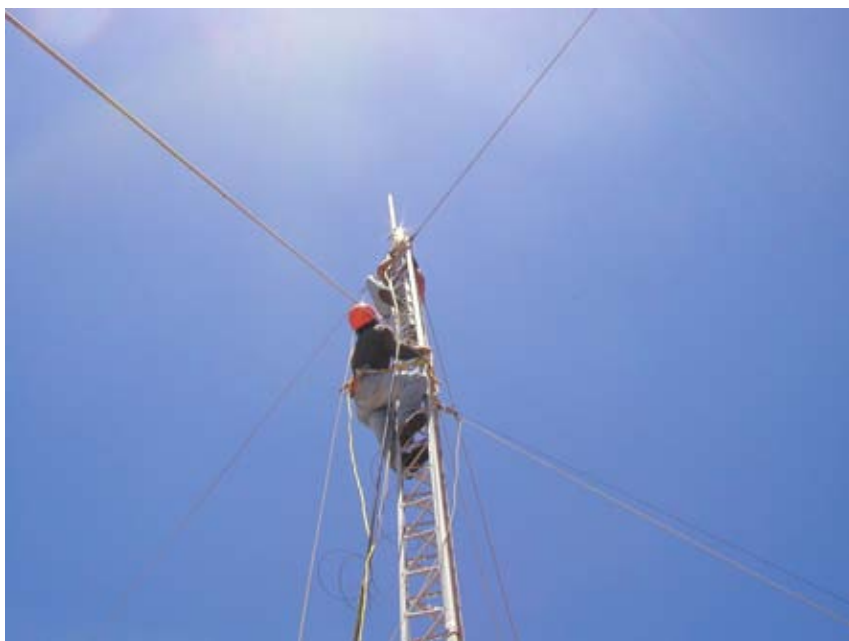
Figura 8.2: Una torre venteada escalable.
