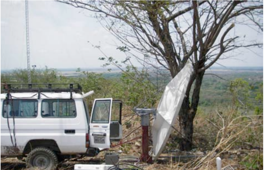
Figura 11.41: Instalación de la antena en El Baúl. La antena está apuntando 1° hacia arriba debido a la iluminación desviada en 22,5°.
