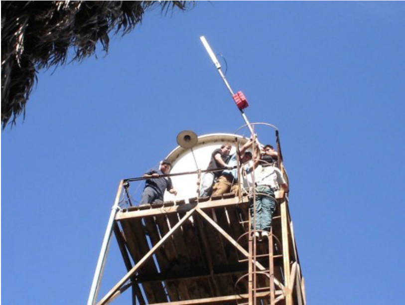
Figura 11.24: Implementación de un nodo sobre una torre de agua en Batuco, Región Metropolitana que enlaza con el telecentro Cabrati.
