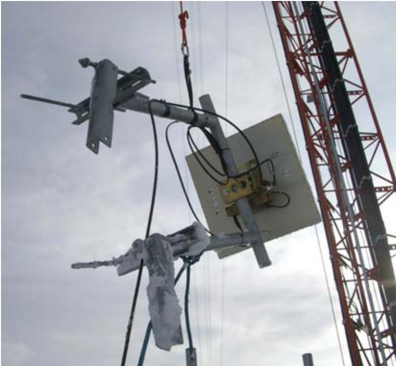
Figura 8.1: Una antena con un soporte de separación instalándose en una torre.
