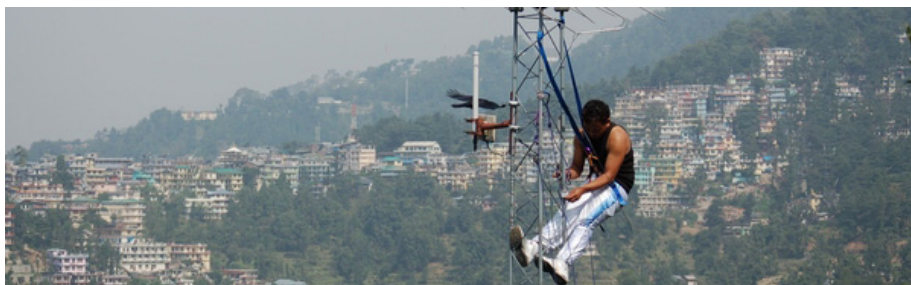
Figura 11.5: Instalador trabajando en una torre en Dharamsala
